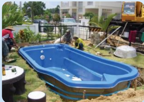
05. การติดตั้งอุปกรณ์งานระบบกรอง, งานไฟฟ้า
