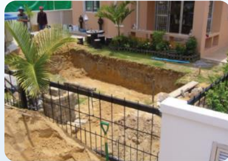
02. ขุดดินเตรียมพื้นที่ลงสระ
