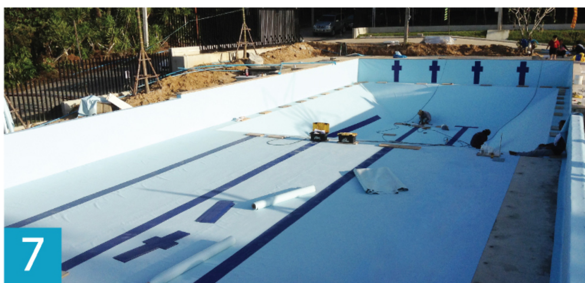
PVC lining complete ติดตั้งไลเนอร์ผนัง พื้น
