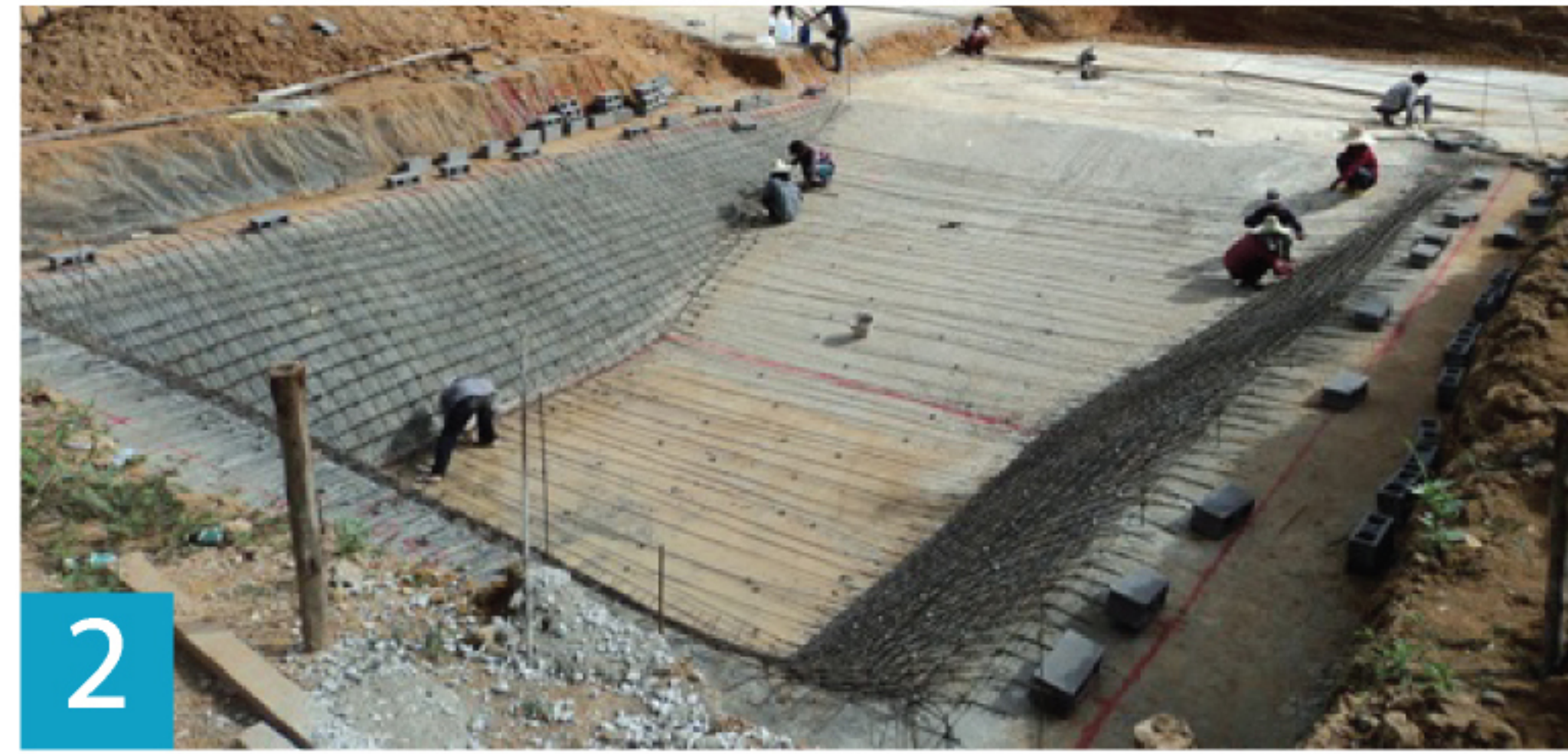
Reinforced Rebar Slab and Levelling Blocks เทเส้นพื้นสระ และวางเหล็กเส้น
