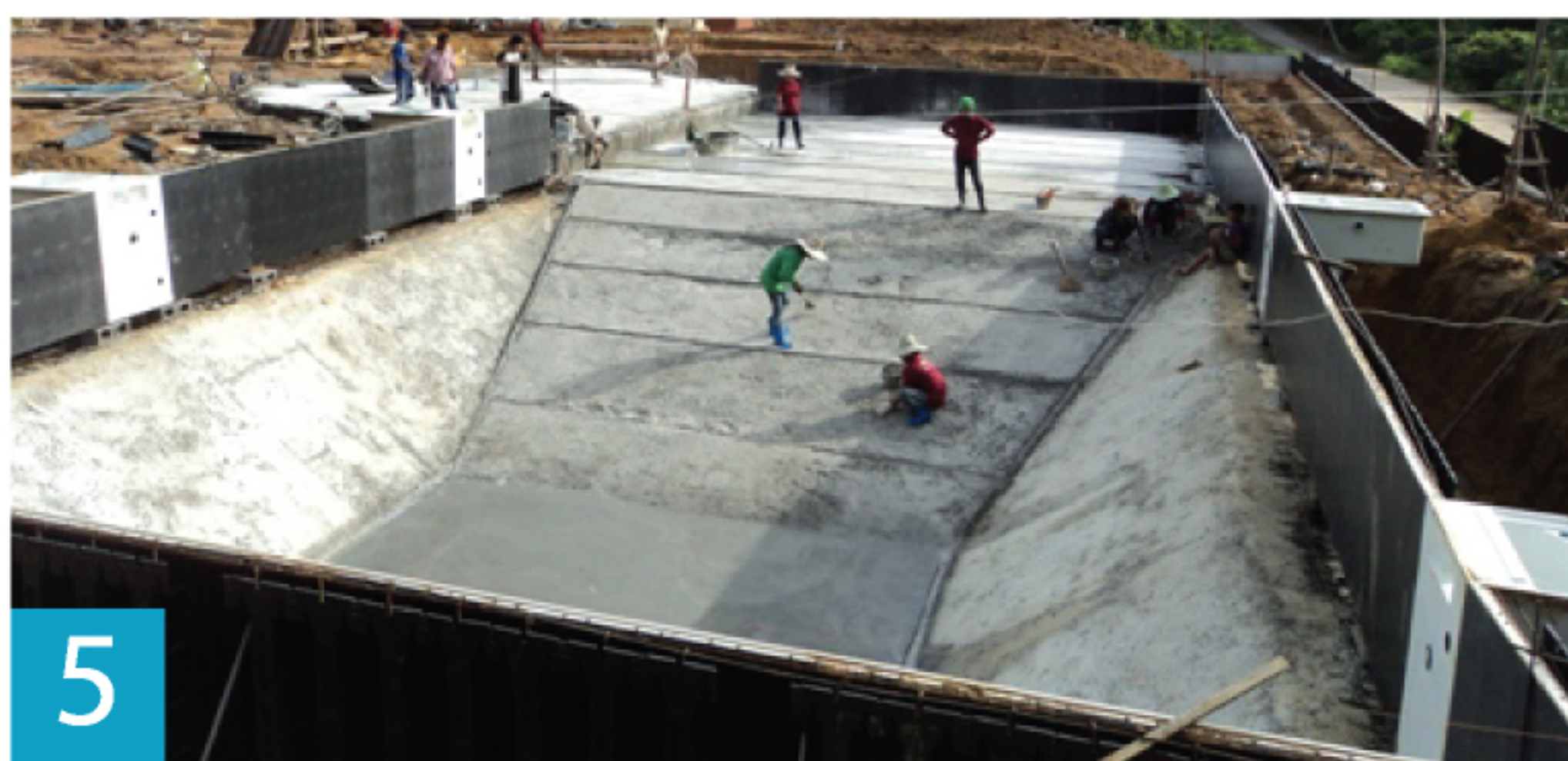
Pours concrete into pool slab and wall in a single process เทคอนกรีตและผนัง พร้อมกันเป็นงานชิ้นเดียว
