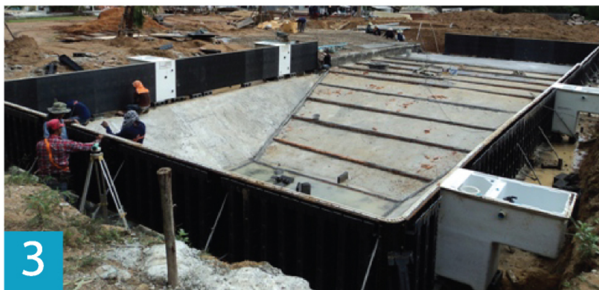
Assembly of Permanent iPanel เตรียมผนังสำเร็จตามแบบ และตั้งผนัง
