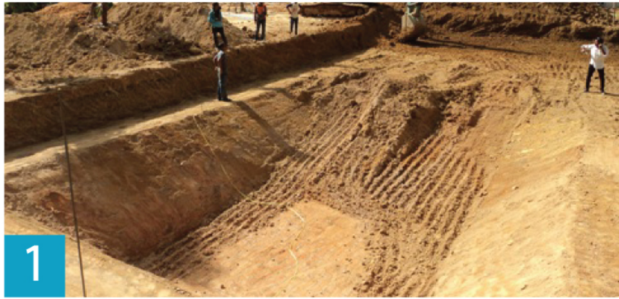
Layout and Excavation วางผังและขุดดิน
