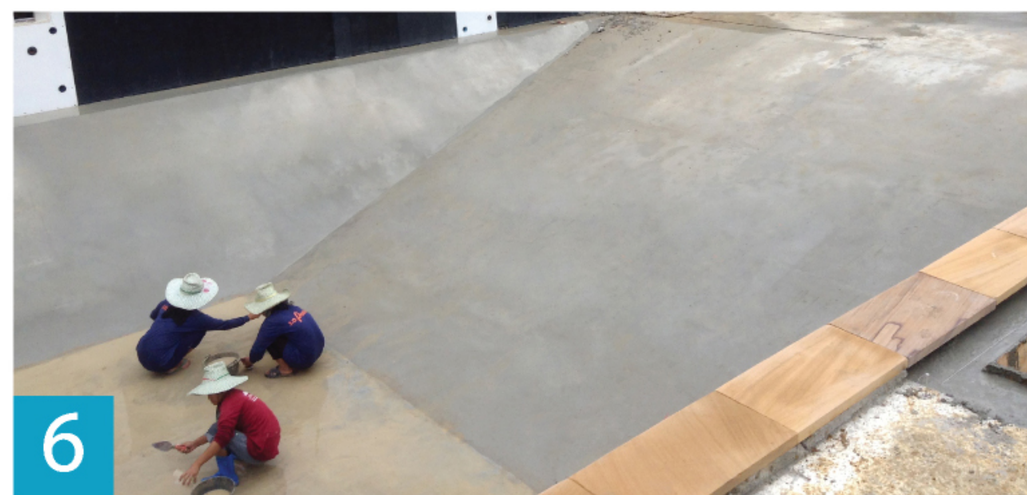
Laying coping stones and then ready for PVC lining วางหินทรายขอบสระ และเตรียมงานไลเนอร์
